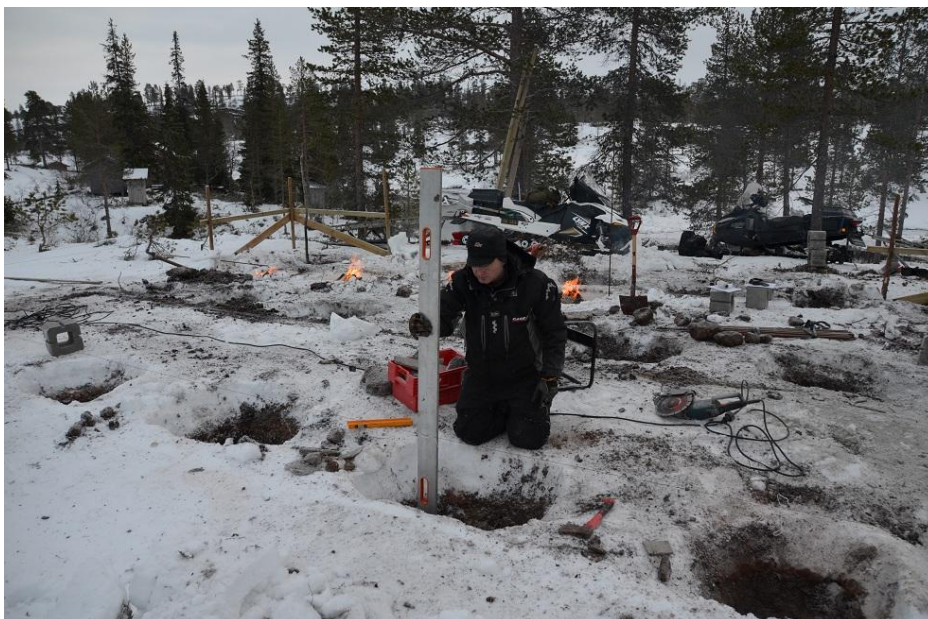
Forberedende arbeid til ny fjellstyrehytte ved Andorsjøen
