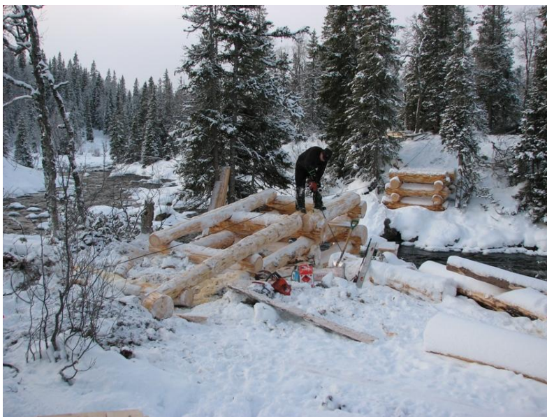
Bruarbeid ved Langvasselva på førjulsvinteren
